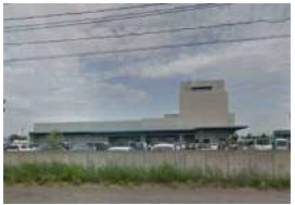
青森市卸売市場水産冷蔵庫
