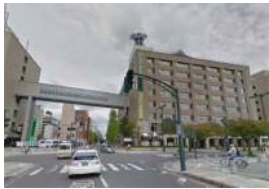
青森県庁舎北棟
