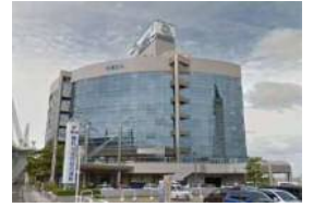
青森県水産ビル
